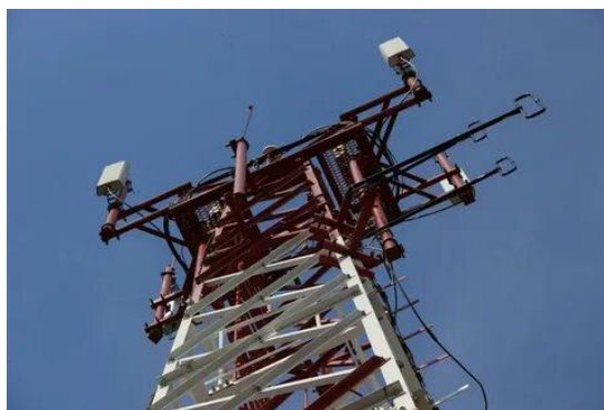
(рис.6-базовая станция стандарта GSM-R. GSM-R)
